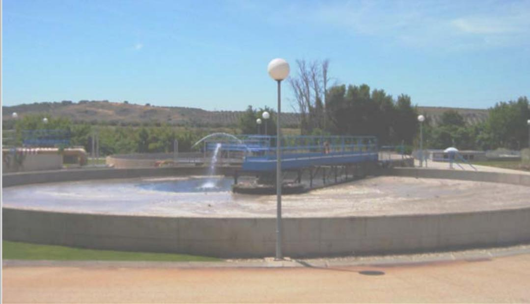
Decantador secundario circular. Se puede observar en la superficie una capa de fangos flotantes, característica que los diferencia de los decantadores primarios. También es de destacar los chorros de agua dirigidos hacia la superficie con objeto de romper las espumas superficiales y mejorar la decantabilidad del fango.
