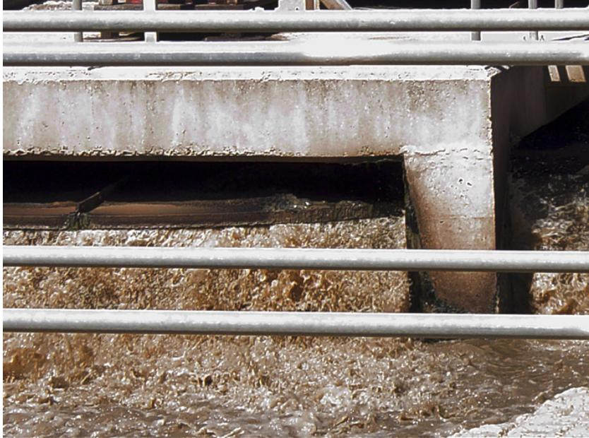
El rotor del tanque de digestión produce la turbulencia necesaria para mantener la biomasa en suspensión y el contacto aire-agua para que la aireación sea correcta. El digestor se comporta como un tanque de mezcla perfecta.
