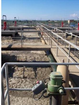
Un reactor continuo de mezcla perfecta es aquel cuyas propiedades son iguales en toda la masa de reacción y coinciden con las de la mezcla de reacción a la salida del mismo ( $F_A$ ). Actúan como balsa de homogeneización, de manera que las condiciones en el mismo son bastante estables en el tiempo, pudiendo asumir tanto puntas de carga como fluctuaciones de caudal.
