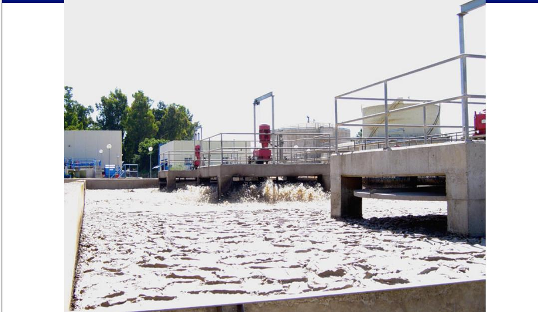
El tanque de digestión posee varios agitadores con objeto de que modificando el número de ellos que está en funcionamiento y la velocidad de cada uno se pueda controlar tanto el grado de mezcla (siempre debe estar asegurado) como el nivel de aireación.
