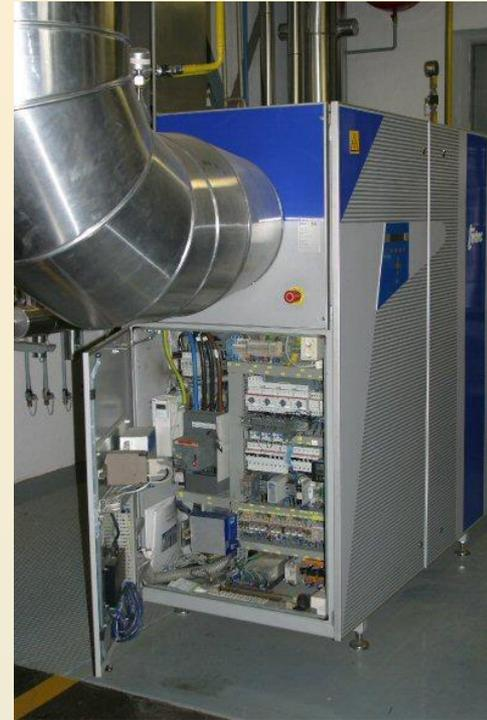
Microturbina comercial Turbec T100 de 100 kWe. Destaca el gran tamaño del regenerador. Fuente: <http://www.turbec.com/>
