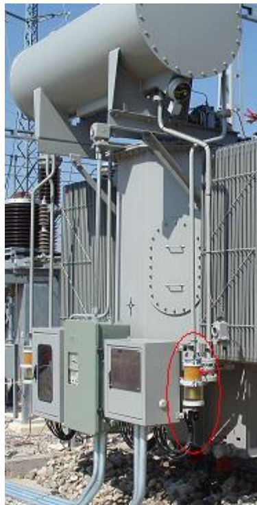
Figura 2.12: Transformador con sistema de preservación del aceite por respiración (encerrado en un círculo rojo está el desecador de silicagel)
