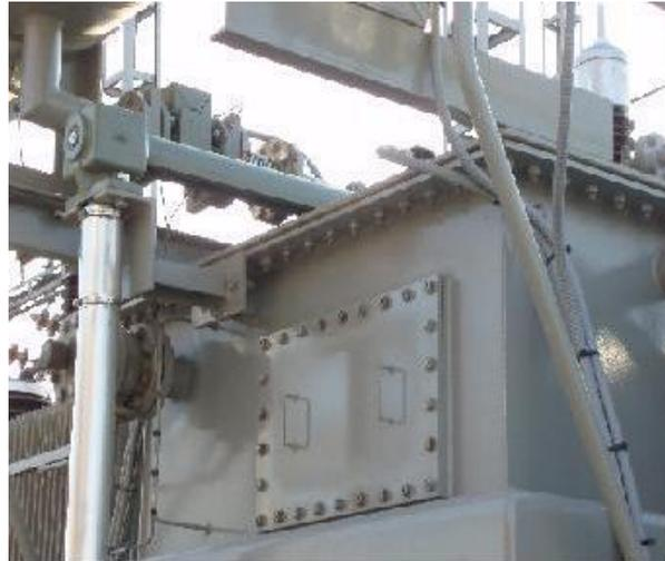
Figura 4.30: Boca de hombre para la inspección del selector en cambiadores de tomas internos. En la figura se observa, además, parte del árbol de transmisión mecánica entre la caja de mando del regulador (situada por debajo de la fotografía, a la izquierda) y la tapa del regulador.
