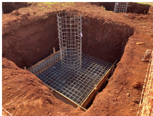
Figura: Ferralla para hormigón armado
