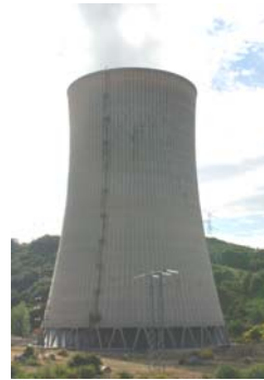
Torre de refrigeración
